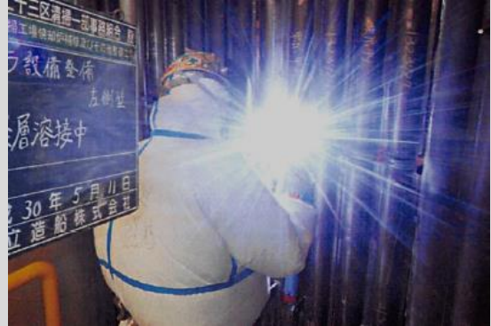
《ボイラ水管補修の様子》
