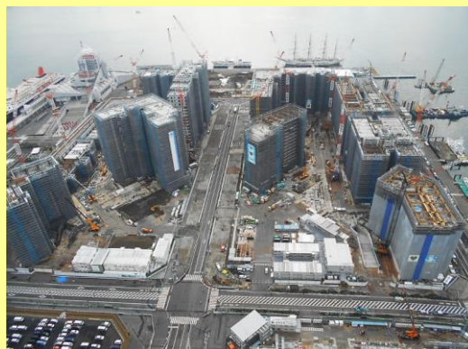
《煙突から見た様子》
