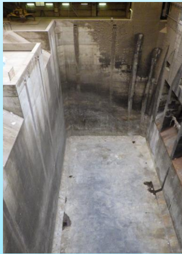
《ごみ撤去後の様子》
