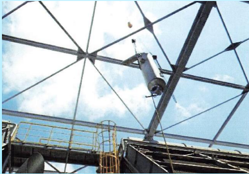
《既設機器の撤去作業の様子》
