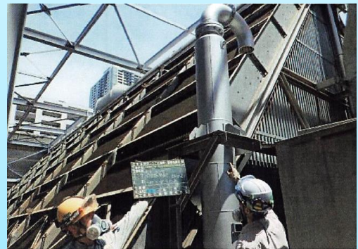
《消音器の設置作業の様子》
