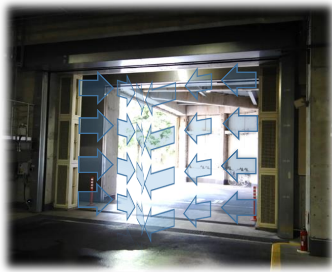
シャッターが開いたとき（矢印：空気の流れ）
