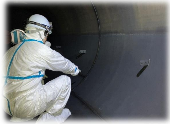
ボイラドラム内部の点検
