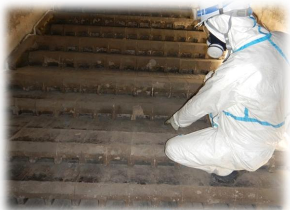
焼却炉内火格子の点検
