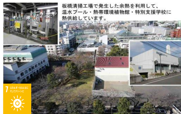
【熱供給】板橋特別支援学校・高島平温水プールが該当
