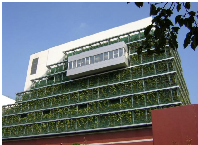
～工場棟の壁面～
