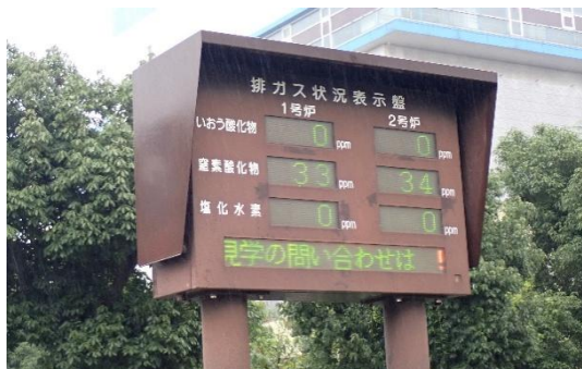
排ガス状況表示盤
