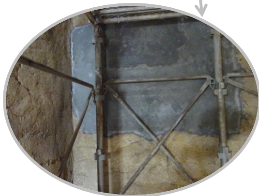
<耐火物補修後の様子>
