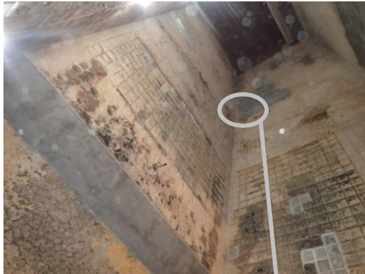
<焼却炉内の様子>
