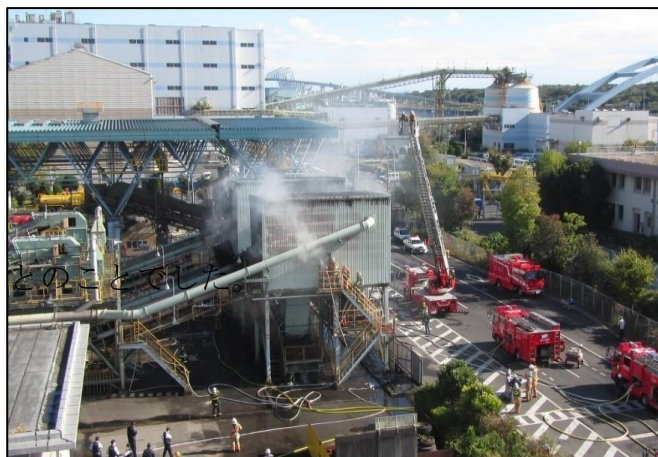
〈粗大ごみ破碎処理施設の火災の様子〉
