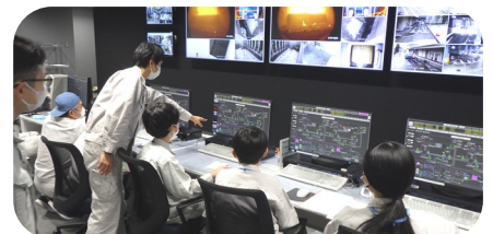
中央制御室での運転監視業務体験
