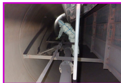
ボイラドラム内部の点検
