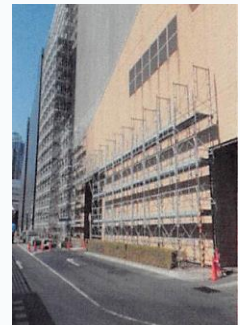
(参考) 有明清掃工場 延命化工事外壁補修写真
