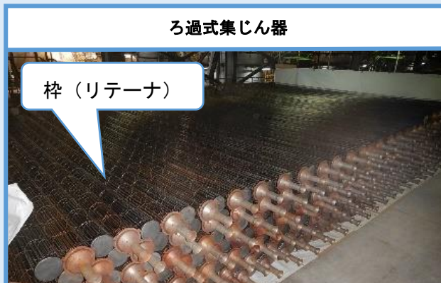
ろ過式集じん器のろ布を取り付けるための枠（リテーナ）を取り外して、新しいろ布に交換していきます。
