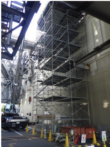
煙道更新のための作業足場
