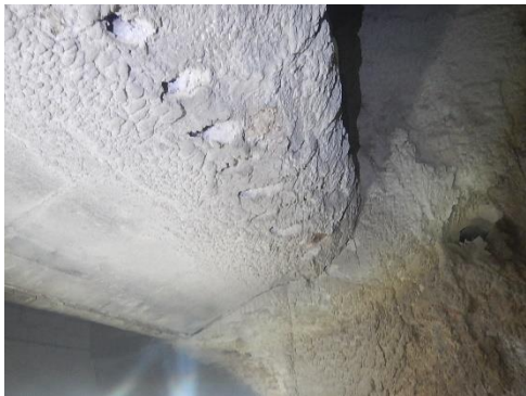
焼却炉内清掃前の様子（灰の堆積）
