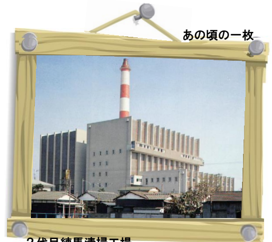
あの頃の一枚 2代目練馬清掃工場 石神井清掃工場と呼ばれていました 昭和44年しゅん工 東京都で初の蒸気発電機能を導入しました 定格出力1,500kW 現在の工場は定格出力18,700kW!
