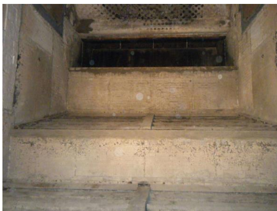
点検後の焼却炉内部
