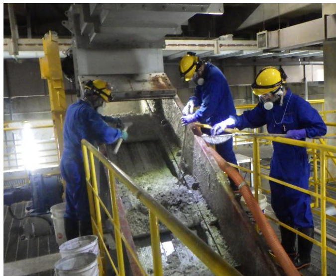
除去作業の様子
