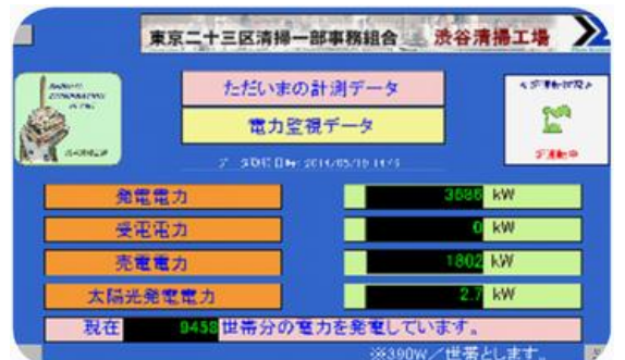
モニター画面で発電電力などが確認できます。
