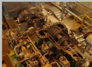
蒸気タービン (開放点検中)
