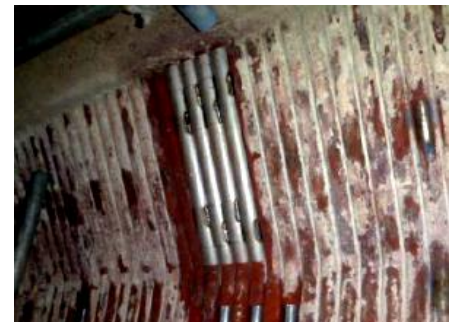
傷んだ設備の補修などを行います （ボイラ水管）
