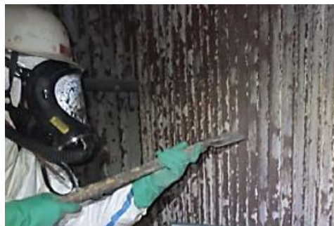
プラント設備に付着・堆積した灰等を清掃します （左：焼却炉内部 右：ボイラ水管）
