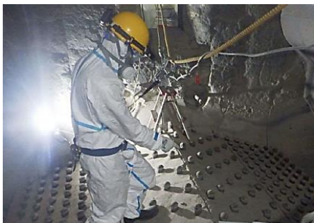
プラント設備に付着・堆積した灰等を清掃します （左：焼却炉内部 右：ボイラ水管）
