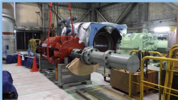
(蒸気タービン発電機点検整備の様子)
