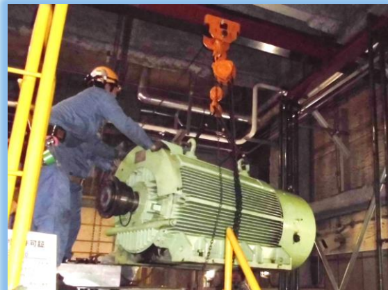
（誘引ファン電動機を整備工場へ搬出する様子）
