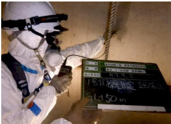
肉厚測定の様子 煙突内壁を超音波厚さ計 で確認中
