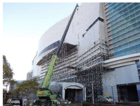
仮設足場の組立ての様子
