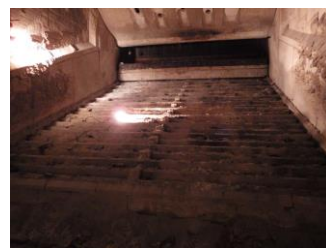
【清掃前の焼却炉内】
