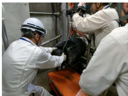
電動機吊り上げ作業
