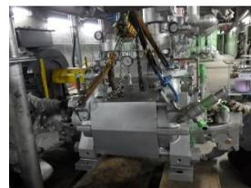
ボイラ給水ポンプの補修（取外し中）
