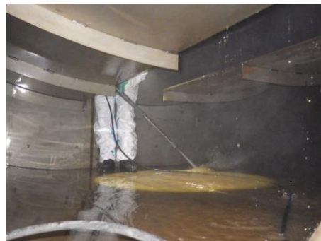
煙道清掃の様子（水洗）
