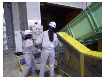
点検作業の様子
