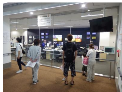
中央制御室見学
