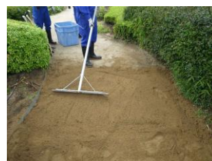
路面補修の様子
