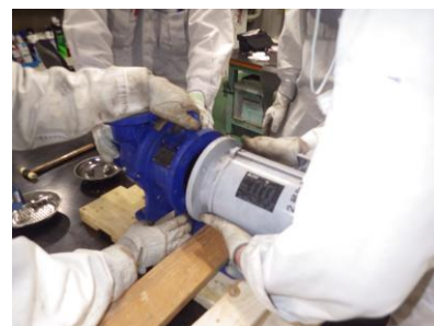
補修作業の様子
