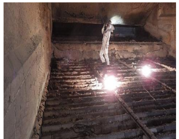
焼却炉内の点検の様子
