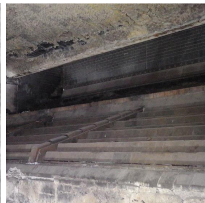
火格子補修後
