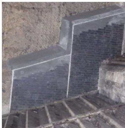
耐火レンガ補修後
