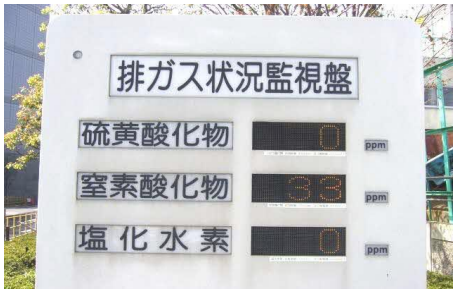
排ガス状況監視盤
