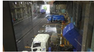
7 プラットホーム
