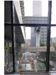
6 ごみ計量器と煙突
