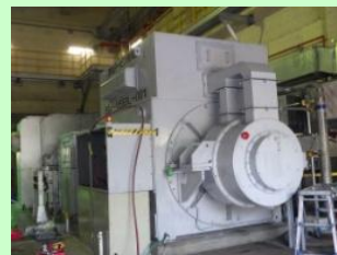
蒸気タービン発電機
