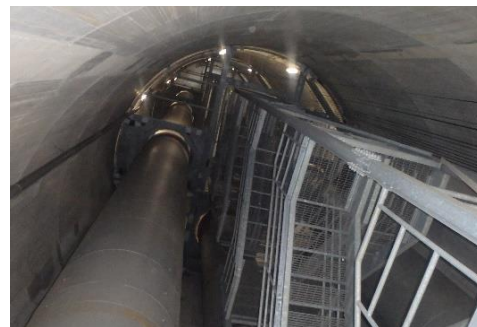
【煙突内部から見上げた写真】
