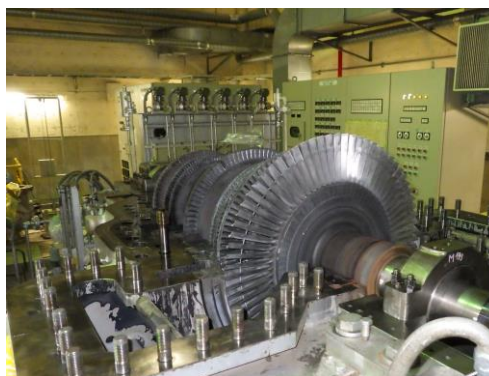
蒸気タービンを開放している様子
