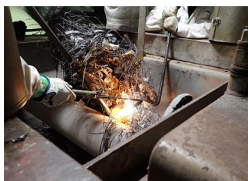
ガス溶断機による不燃物の切断
