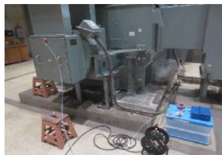
発電機の絶縁劣化診断
