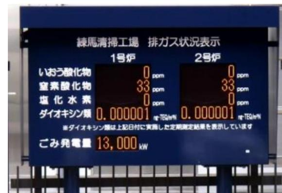
测定排气中的有害物质，在清扫工厂入口等处设置的排气状况显示盘上实时显示。
