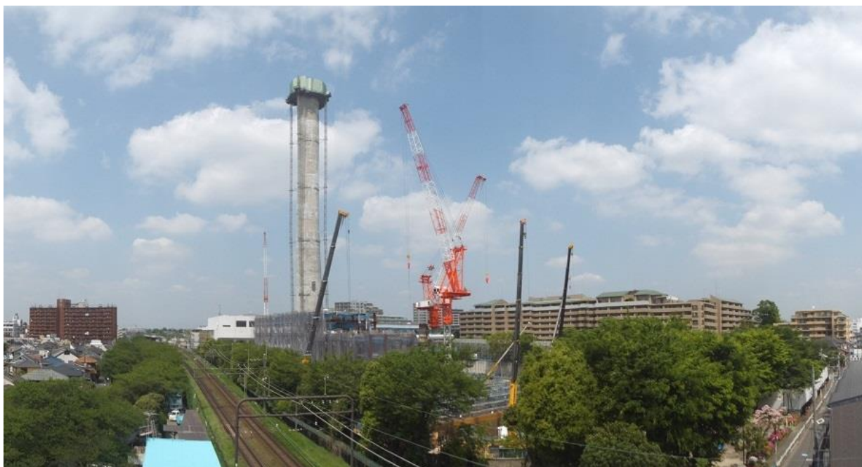
杉並清掃工場(建設工事中)
