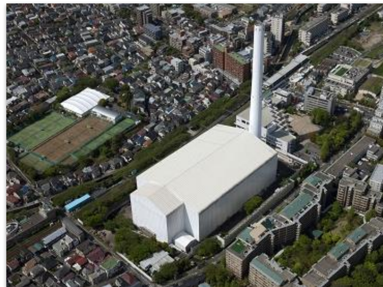
全覆い仮設テント
