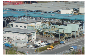
粗大ごみ破碎処理施設
