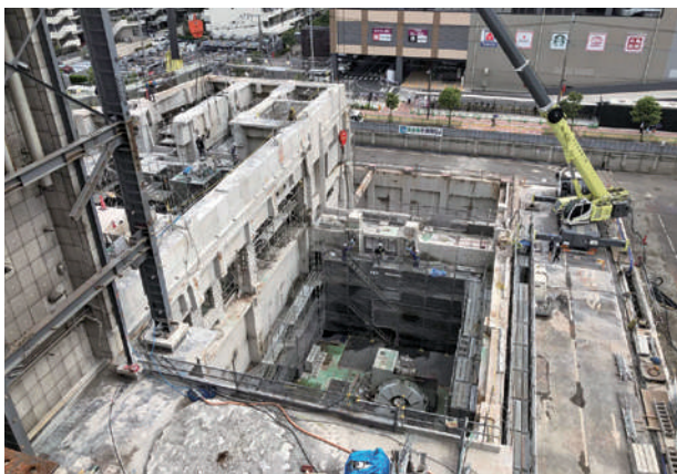
工場棟の解体工事（北清掃工場）
