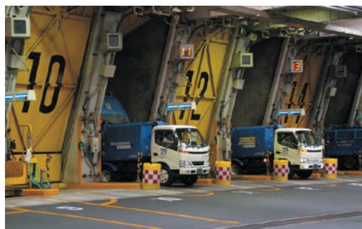
ごみの搬入の様子（足立清掃工場）
