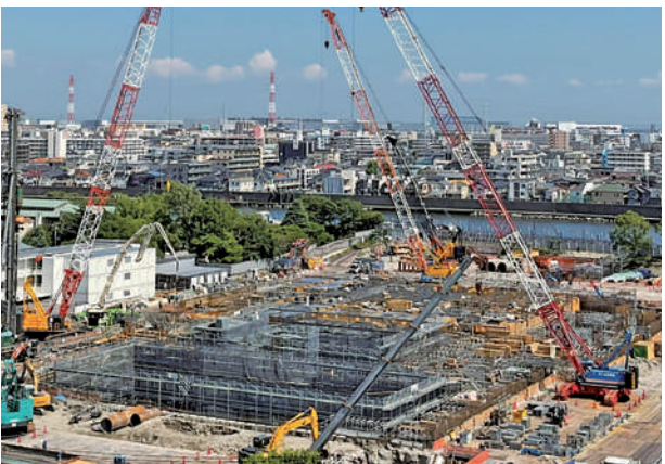
建設工事の全景（江戸川清掃工場）
