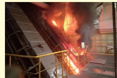
リチウムイオン二次電池によるコンベヤ火災 （中防不燃ごみ処理センター）
