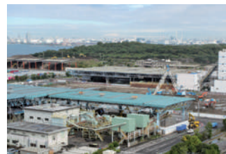
粗大ごみ破碎処理施設
