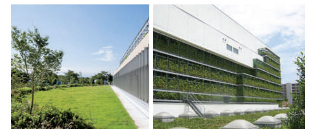
屋上緑化 (杉並清掃工場)
