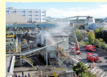
粗大ごみ破碎処理施設での火災
