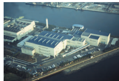
京浜島不燃ごみ処理センター （大田区京浜島）
