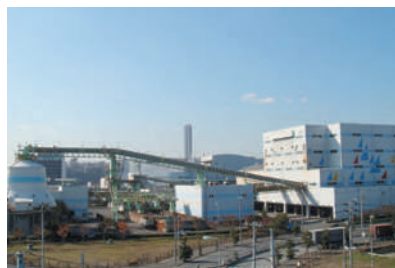
中防不燃ごみ処理センター （江東区海の森）
