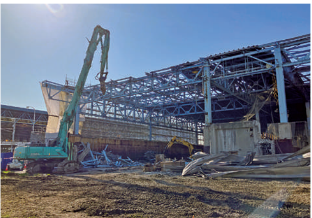
不燃ごみ受入ヤードの解体工事 （中防不燃ごみ処理センター 第一プラント）
