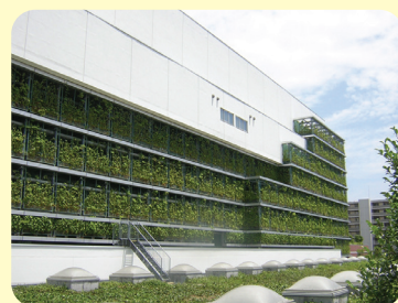
壁面緑化 (板橋清掃工場)
