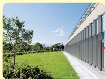
屋上緑化 (杉並清掃工場)
