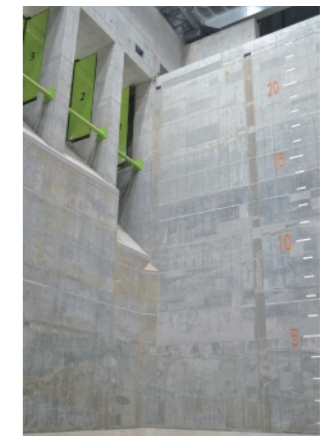
建設中のごみバンカ（目黒清掃工場）
