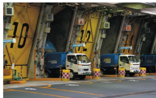
ごみの搬入の様子（足立清掃工場）
