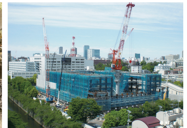
建設工事の全景（目黒清掃工場）
