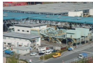
粗大ごみ破碎処理施設
