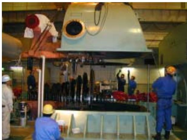
蒸気タービン発電機を整備している様子
