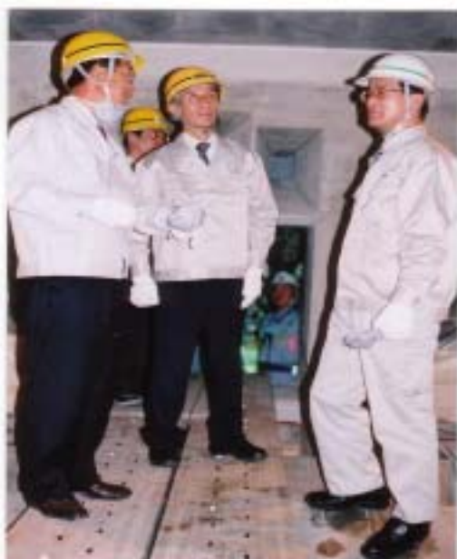
焼却炉内部を視察する 鈴木足立区長
