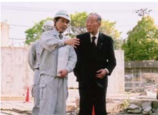
解体工事現場を視察する 室橋管理者
