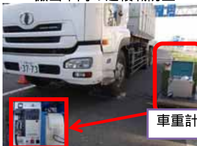
搬出車両の重量計測
