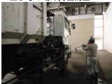
搬出車両はタイヤ等洗浄後出場
