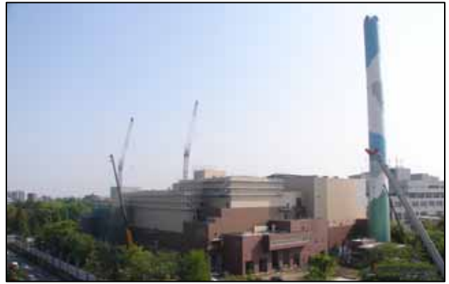
建設工事中の世田谷清掃工場(5月2日撮影)
